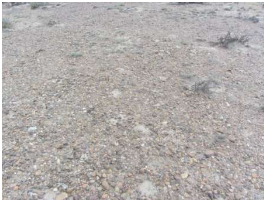
Imagen 17. Vista pavimento de erosión
