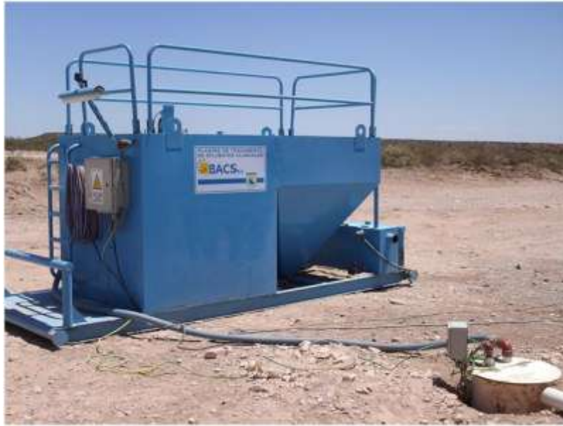
Foto III.B-35. Vista de la Planta de Tratamiento.
