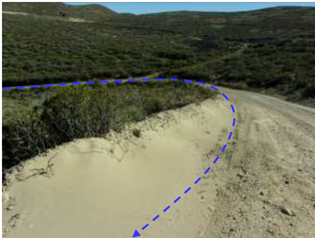
Foto III.B-26. Futura línea de inyección por margen interno de camino. Vista hacia el NO.
