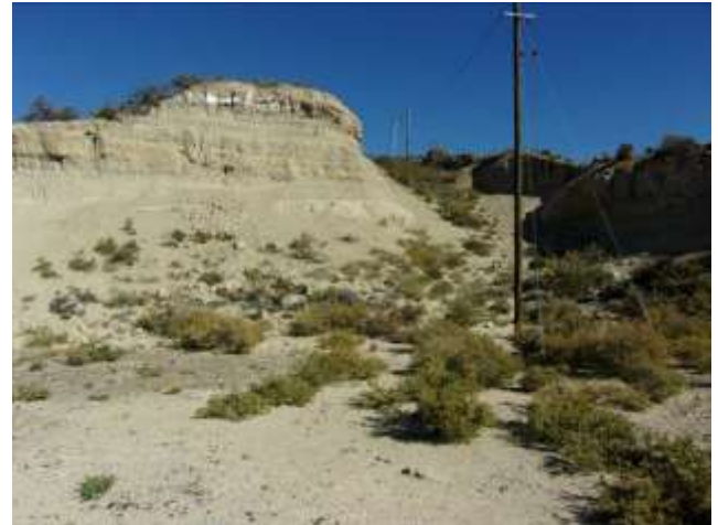
Foto III.B-13. Tendido eléctrico que llega a la locación por el vértice NO. Vista hacia el O.
