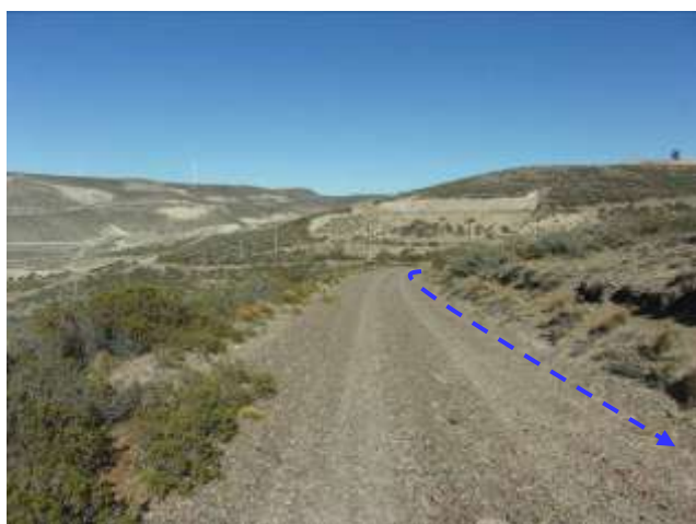
Foto III.B-30. Futura línea de inyección por margen interno de camino. Vista hacia el SO.
