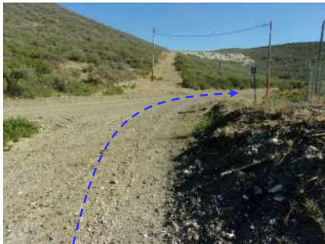
Foto III.B-23. Futura línea de inyección por picada desprovista de vegetación y margen interno de camino. Vista hacia el SE.
