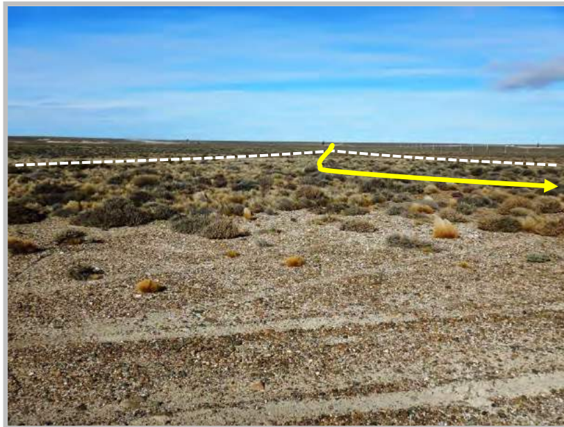
Figura 19: Traza del oleoducto por picada sísmica y luego por el margen del pozo PJ-806. Vista hacia el Sureste.
