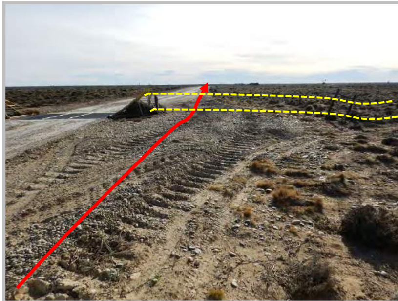
Figura 11: Traza del gasoducto por lateral O, cruce con guardaganado y alambrado. Vista hacia el Norte.
