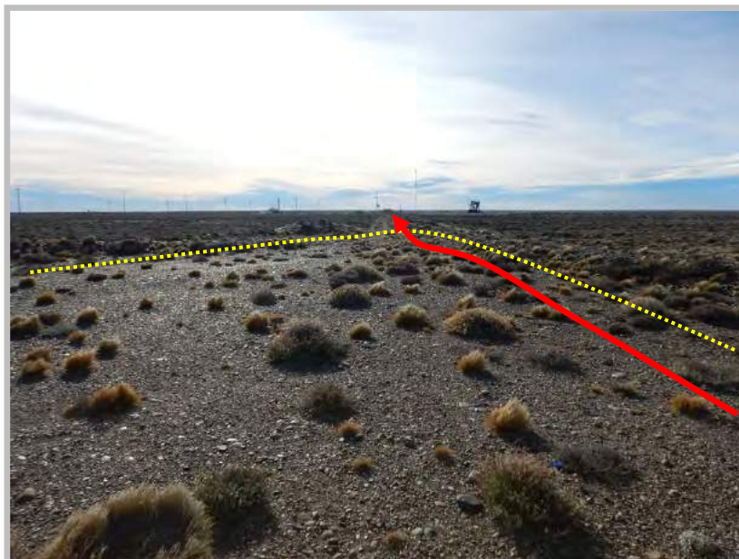
Figura 12: Traza del gasoducto de 4" por margen de la locación del pozo PJ-813, luego continua por picada existente. Vista hacia el Noreste.
