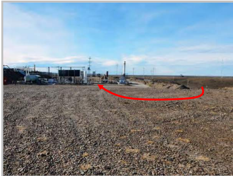
Figura 15: Acometida de la traza del gasoducto en la Batería Jorge 1. Vista hacia el Este.
