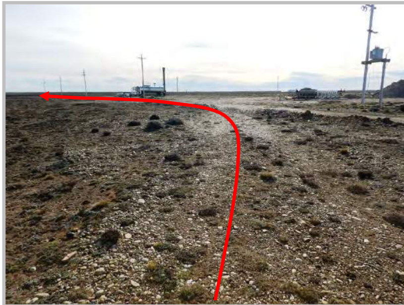
Figura 13: Traza del gasoducto por picada preexistente. Vista hacia el Noreste.
