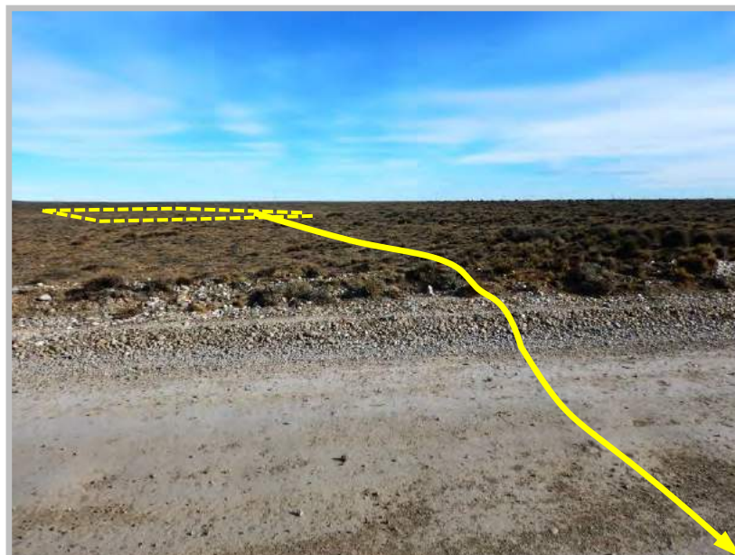
Figura 16: Inicio de la traza del oleoducto de 6" desde la ubicación de la futura Batería JO2 (en línea punteada). Se observa cruce de la traza con camino secundario. Vista hacia el Oeste.
