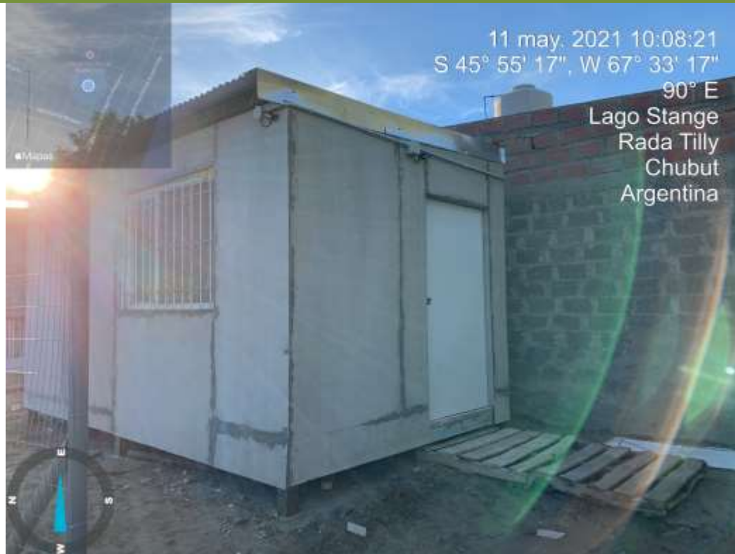
Imagen 2: Vista del Recinto de acopio transitorio de residuos biopatogénicos.
