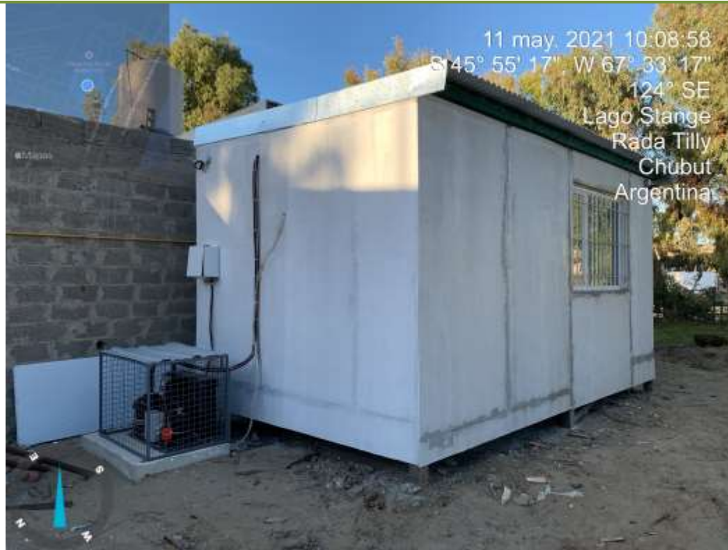
Imagen 4: Equipo de refrigeración.
