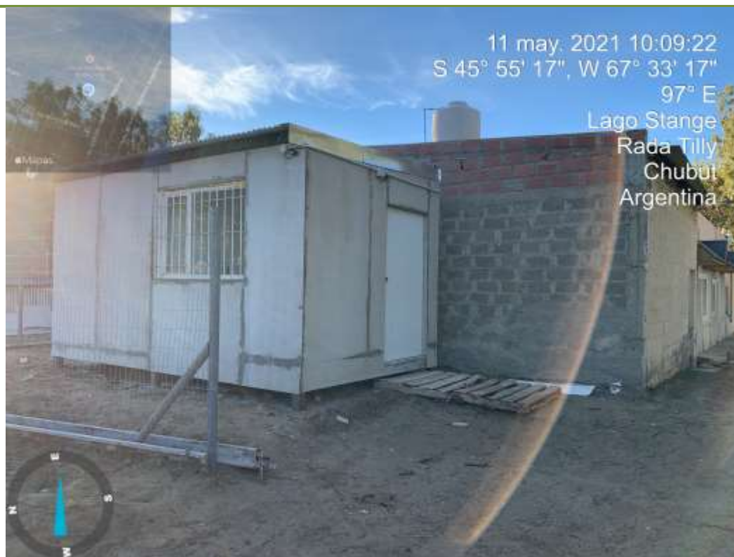
Imagen 5: Espacio donde se instalará el portón de ingreso.
