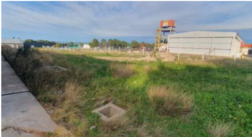
Imagen 16: sitio donde se trasladará la planta de tratamiento de efluentes, vista hacia el Sur.
