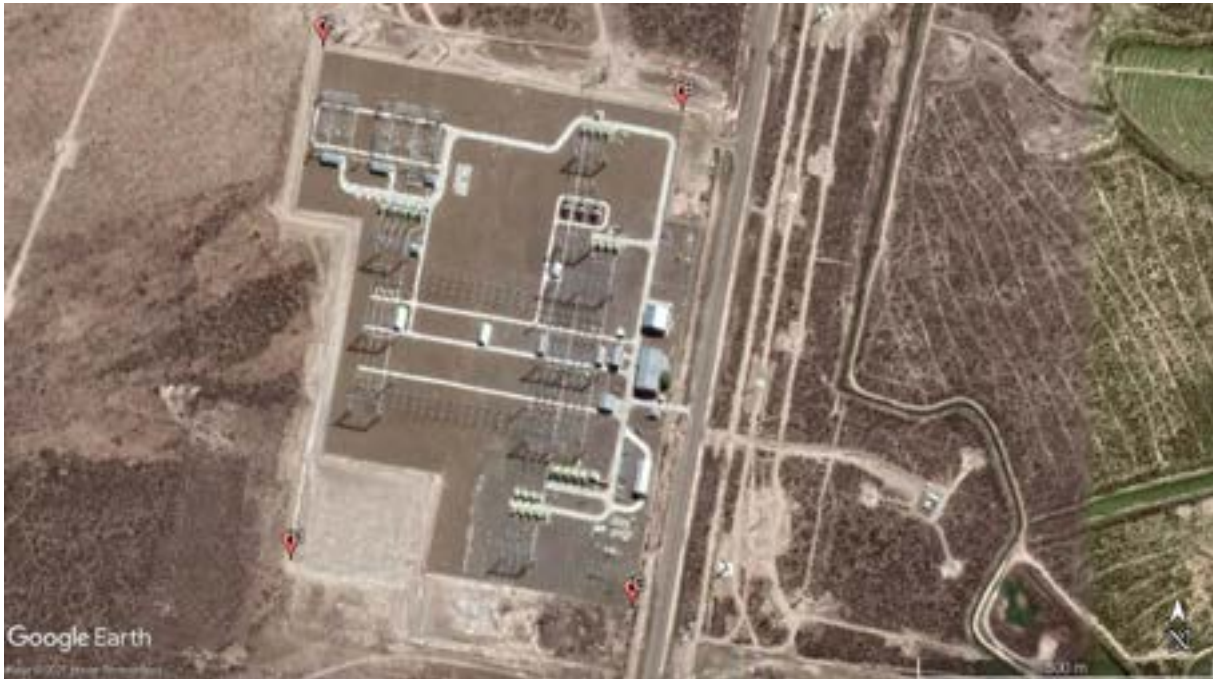
Figura 3.3 Predio de la Estación Transformadora Puerto Madryn de TRANSENER.
