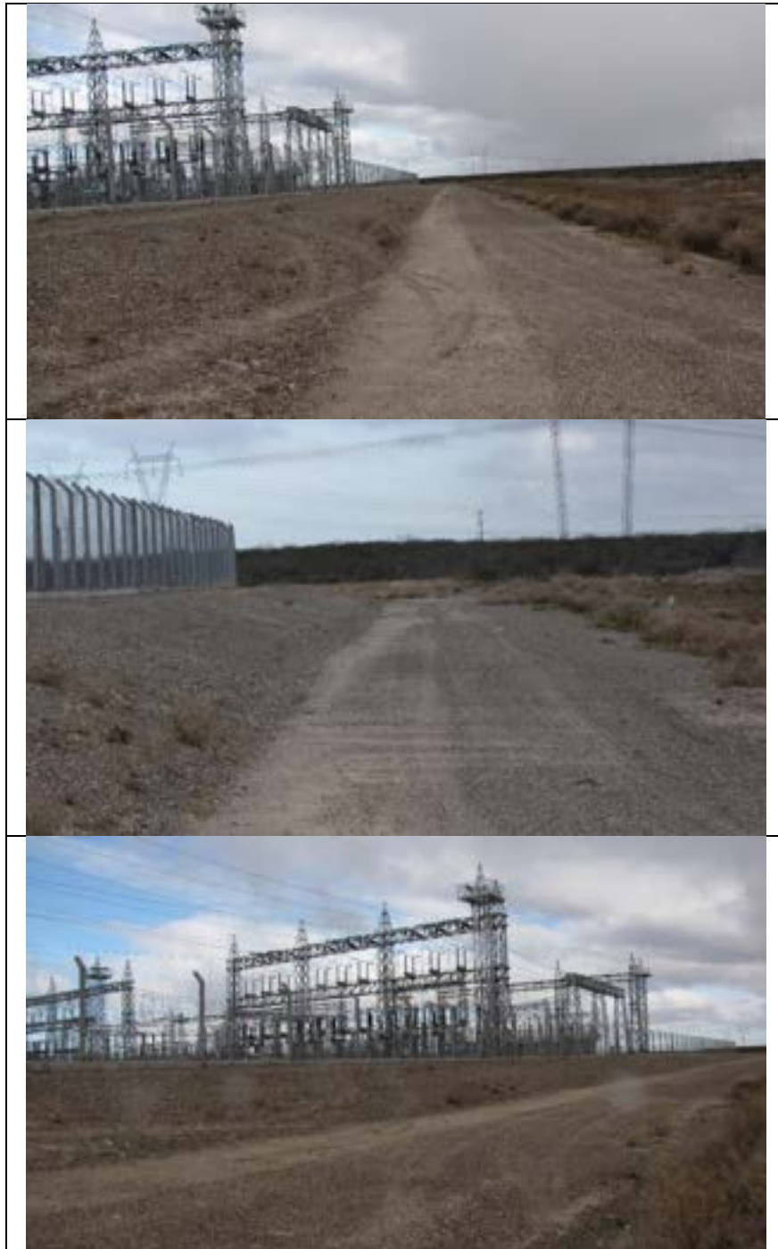
Figura 4.8.33 Zona de relevamiento 8. Lateral NW lindero con zonas de ampliación.
