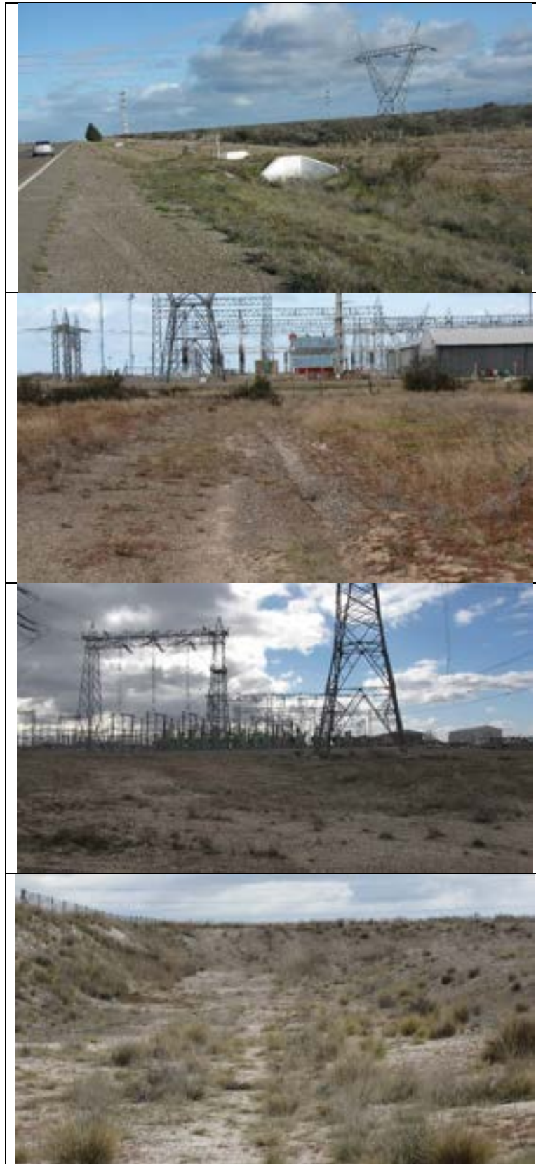
Figura 4.8.29 Zona de relevamiento 4. Lateral sur, posible ingreso a obra.
