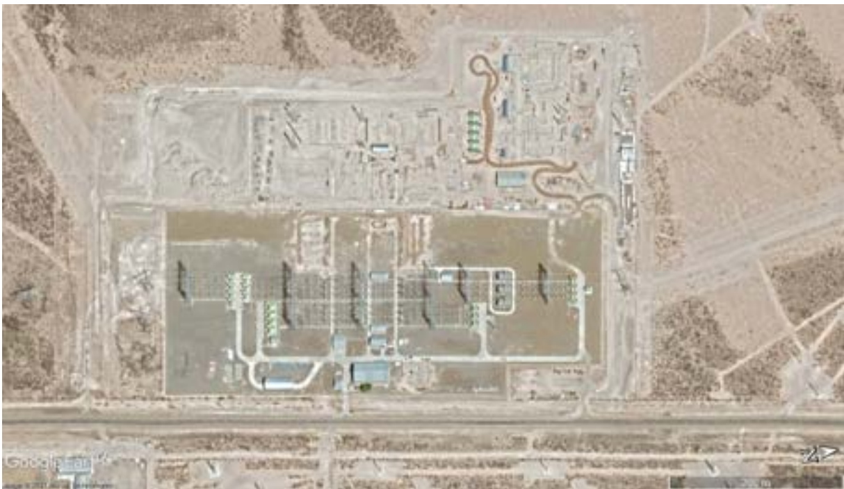
Figura 4.7.21 Imagen satelital de la ETPY. Ene-19. Nueva ampliación al oeste.
