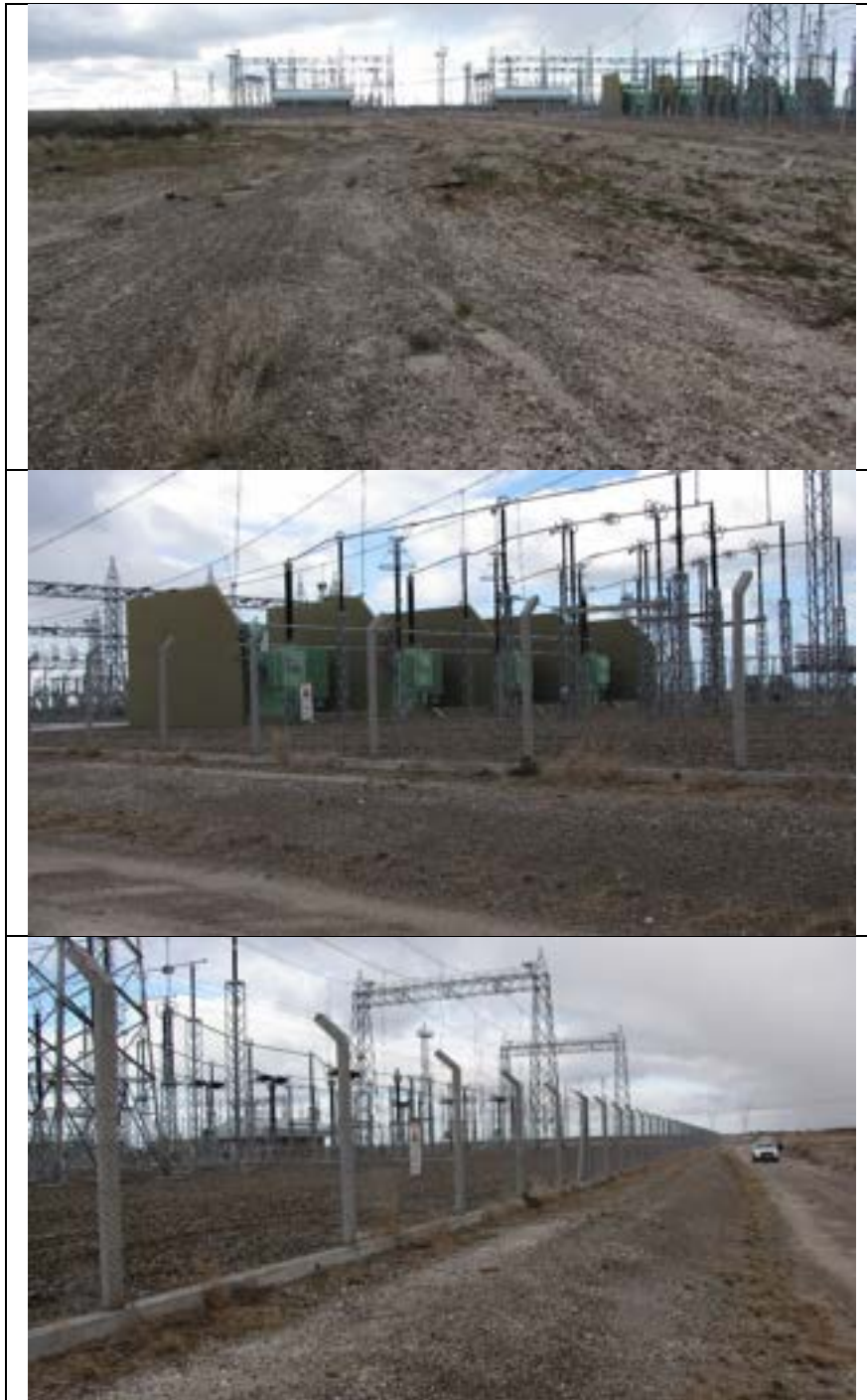
Figura 4.8.32 Zona de relevamiento 7. Vistas externas de la zona de ampliación.
