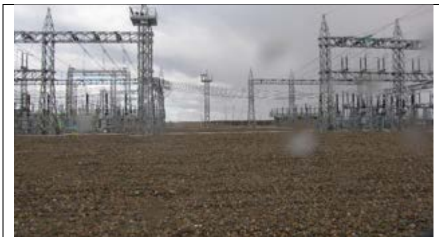
Figura 4.8.35 Zona de relevamiento 10. Zona de ampliación 132 kV, vista desde el norte.
