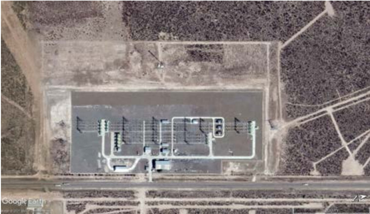
Figura 4.7.20 Imagen satelital de la ETPY. Nov-18. En la ETPY hay un nuevo edificio, y se observan nuevas acometidas de líneas aéreas.
