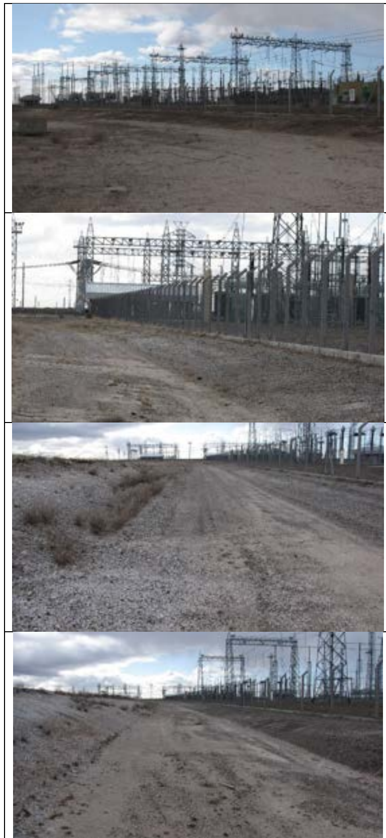
Figura 4.8.31 Zona de relevamiento 6. Lateral oeste, área de ampliación y corrimiento del alambrado perimetral.
