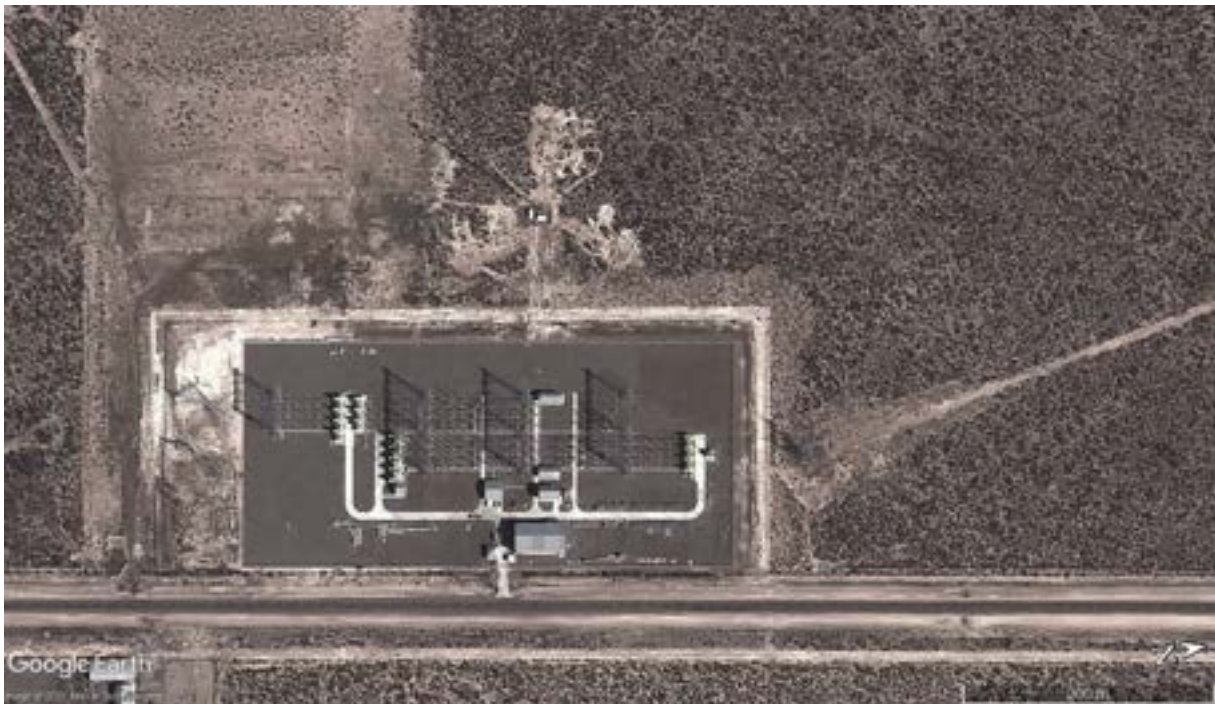
Figura 4.7.17 Imagen satelital de la ETPY. Mar-12. Primera etapa de desarrollo. Al oeste hay una superficie amplia desmontada, y una franja perimetral externa que fue impactada con la construcción.
