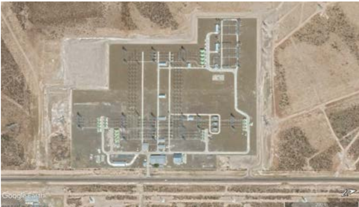
Figura 4.7.23 Imagen satelital de la ETPY. Dic-19. Obras de ampliación finalizadas.
