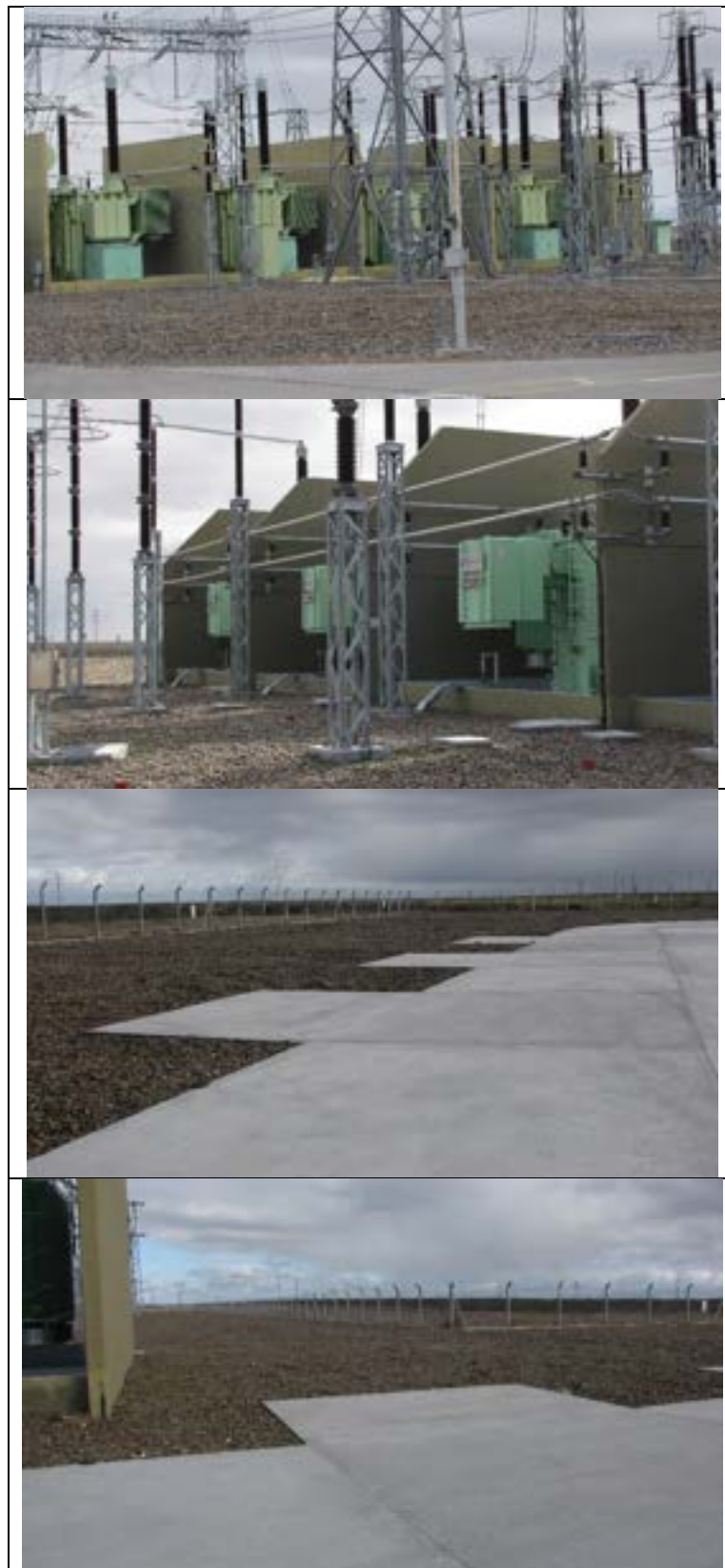
Figura 4.8.38 Zona de relevamiento 13. Área transformadores, sector de ampliación y plateas disponibles.
