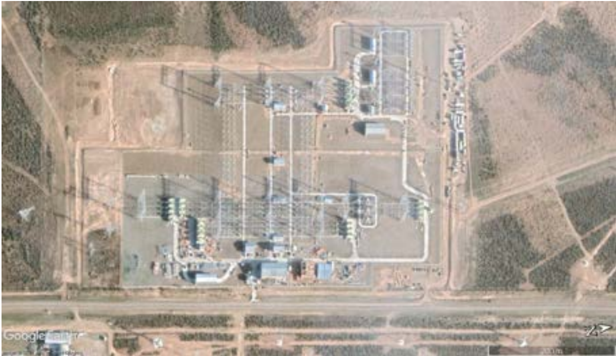
Figura 4.7.22 Imagen satelital de la ETPY. Jun-19. Avance de las obras de ampliación.
