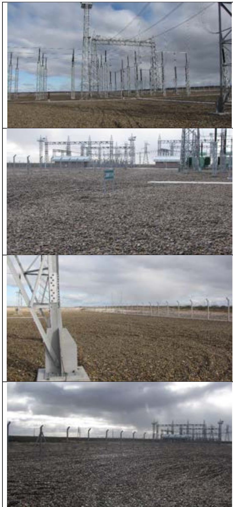
Figura 4.8.39 Zona de relevamiento 14. Sector de ampliación de campos.
