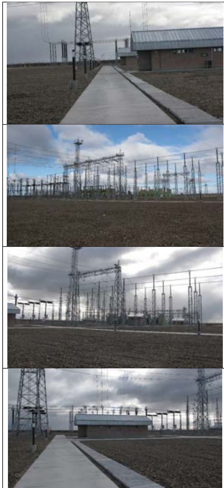
Figura 4.8.37 Zona de relevamiento 12. Interior de la ETPY, configuración actual.
