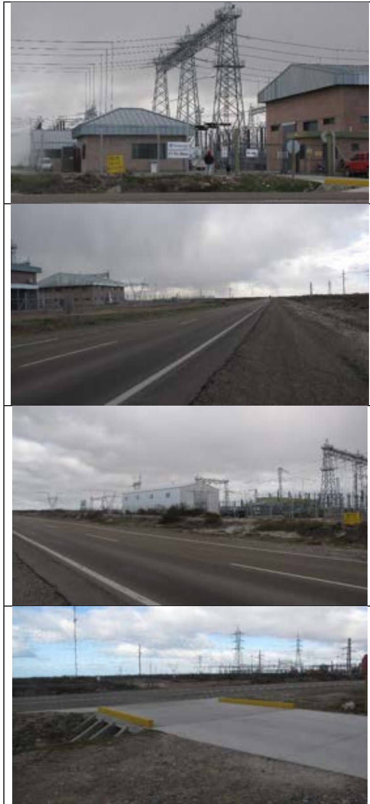
Figura 4.8.26 Zona de relevamiento 1. Ingreso a ETPY, vistas norte, sur y este.
