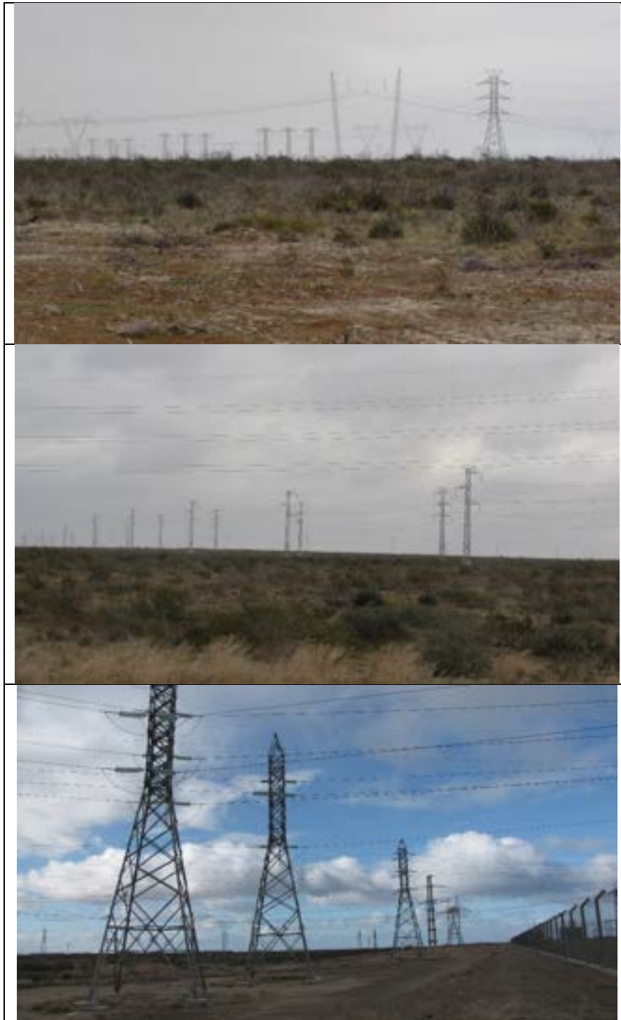
Figura 4.8.28 Zona de relevamiento 3. Líneas áreas al NW.
