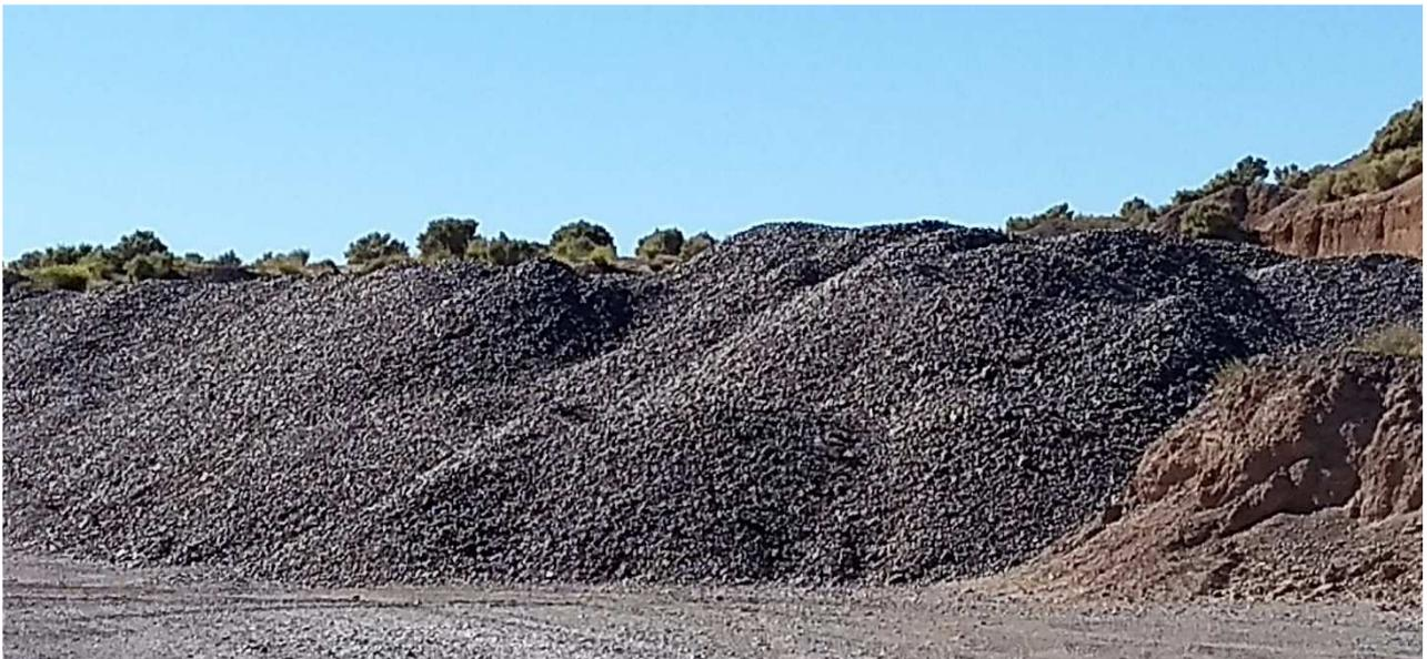
Se produce un material especial para base de ruta, una parte del material que se entrega consiste en la elaboración de material especial para base de ruta reforzada con un 30% de pórfido y con el material humectado al 20%. El procedimiento es extender el ripio en bandas de anchas y largas e irlo mezclando con el porcentaje de pórfido y el agua cruda mediante repetidos movimientos y pasadas con motoniveladora.
