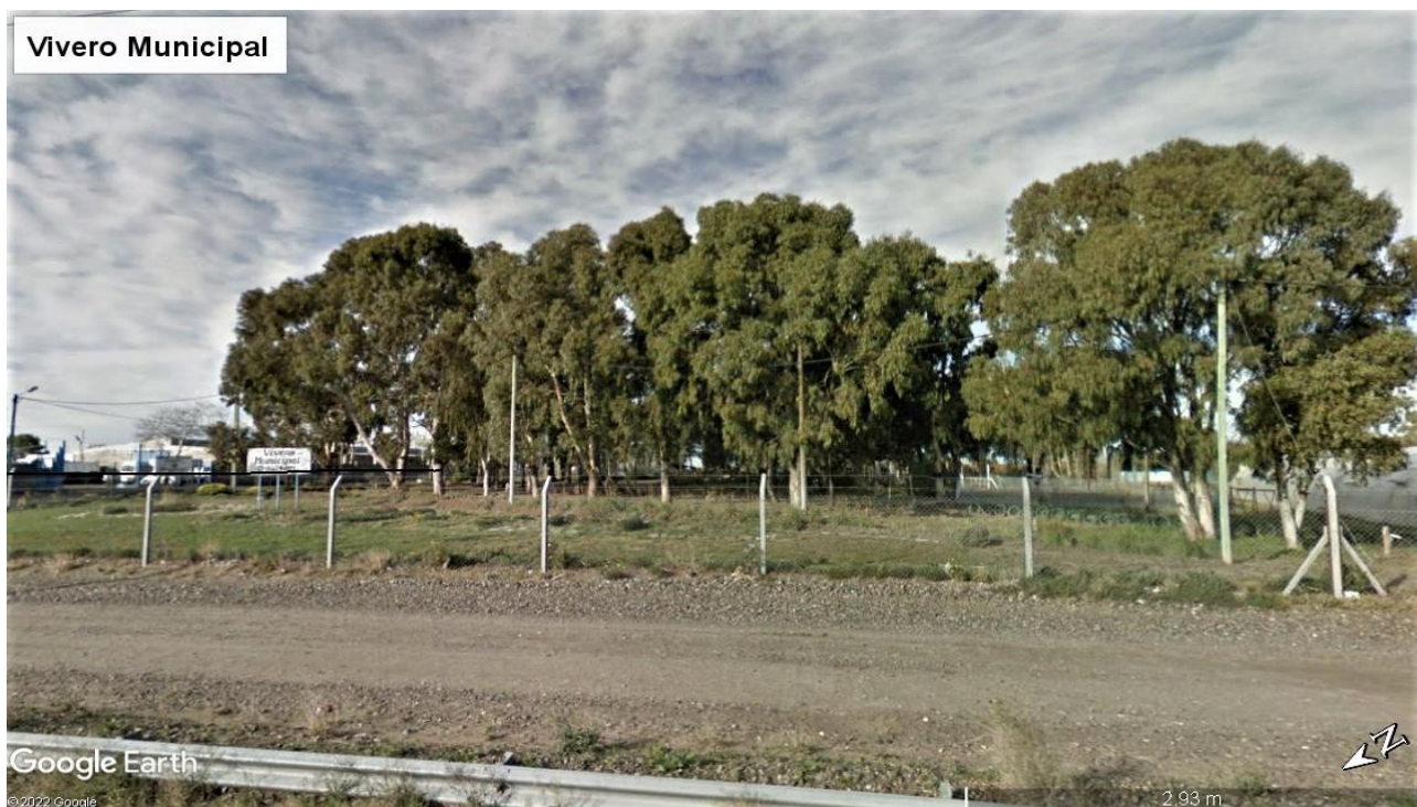
Foto N° 5 Instalaciones del vivero municipal, conformado por construcciones permanentes, banco de semillas e invernáculos.
