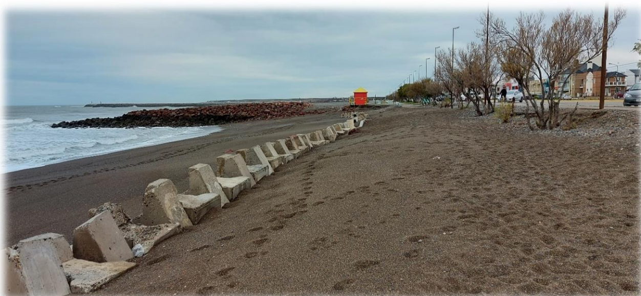
Foto N° 33 Defensas transitorias destinadas a retener sedimentos que son arrastrados por la corriente litoral hacia el norte.
