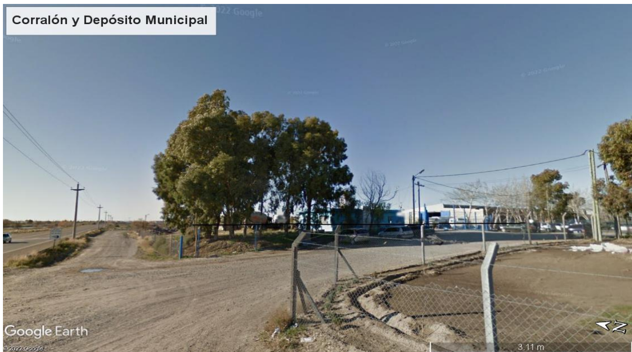
Foto N° 4 Depósito de equipos y materiales del Municipio de la ciudad de Rawson. Sobre el límite Norte del predio del parque.
