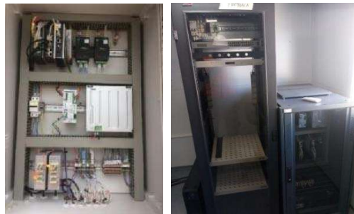
Figura 14. Rack / Gabinete Comunicaciones – SCADA Referenciales
