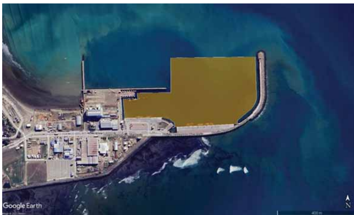
Figura 14. Sector que se prevé será dragado en el proyecto del Puerto de Comodoro Rivadavia.
