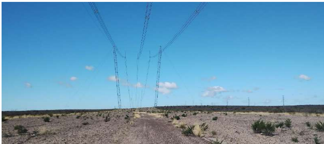
Fotografías 47 y 48. Línea Eléctrica de Alta Tensión de 132 kV Parque Eólico Aluar: San José
