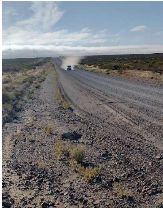
Fotografías 29 y 30. Ruta Provincial N° 4: Vista desde La Flecha
