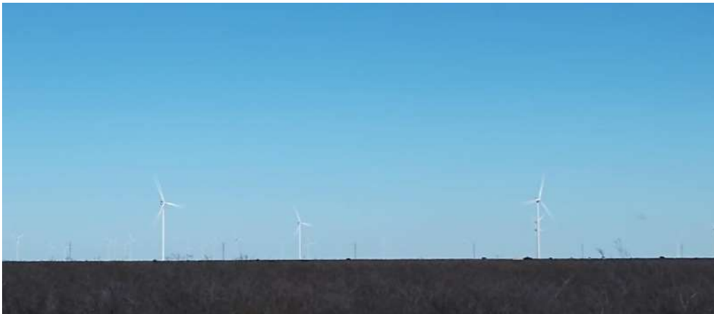
Fotografías 27 y 28. Aerogeneradores Parque Eólico Aluar Etapas I, II, III: Vista desde San José
