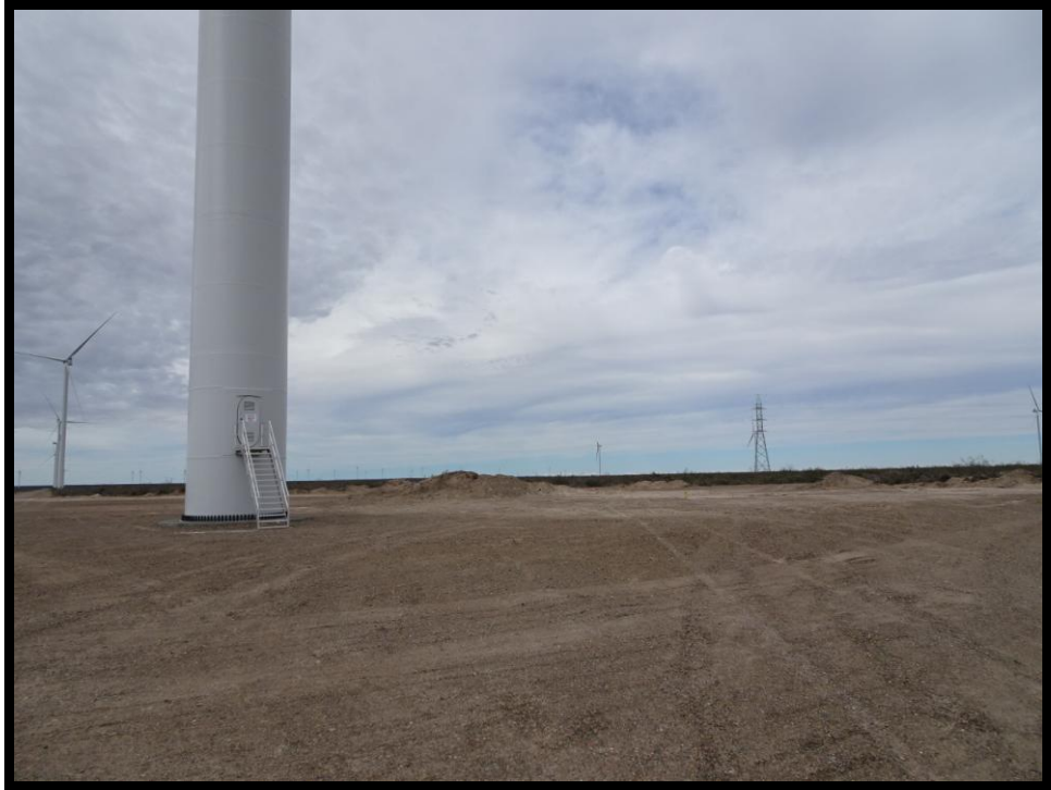
FOTO N° 3: Area cortafuego adyacente al molino
