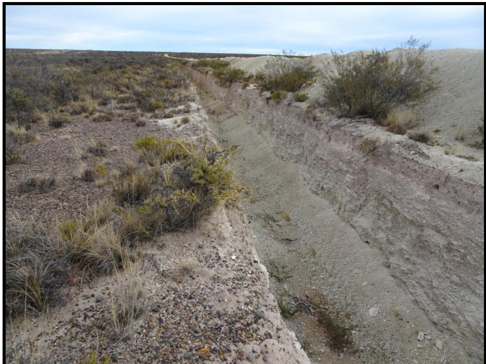
FOTO N° 10: Otra vista del zanjón en el ingreso al Lote 16B
