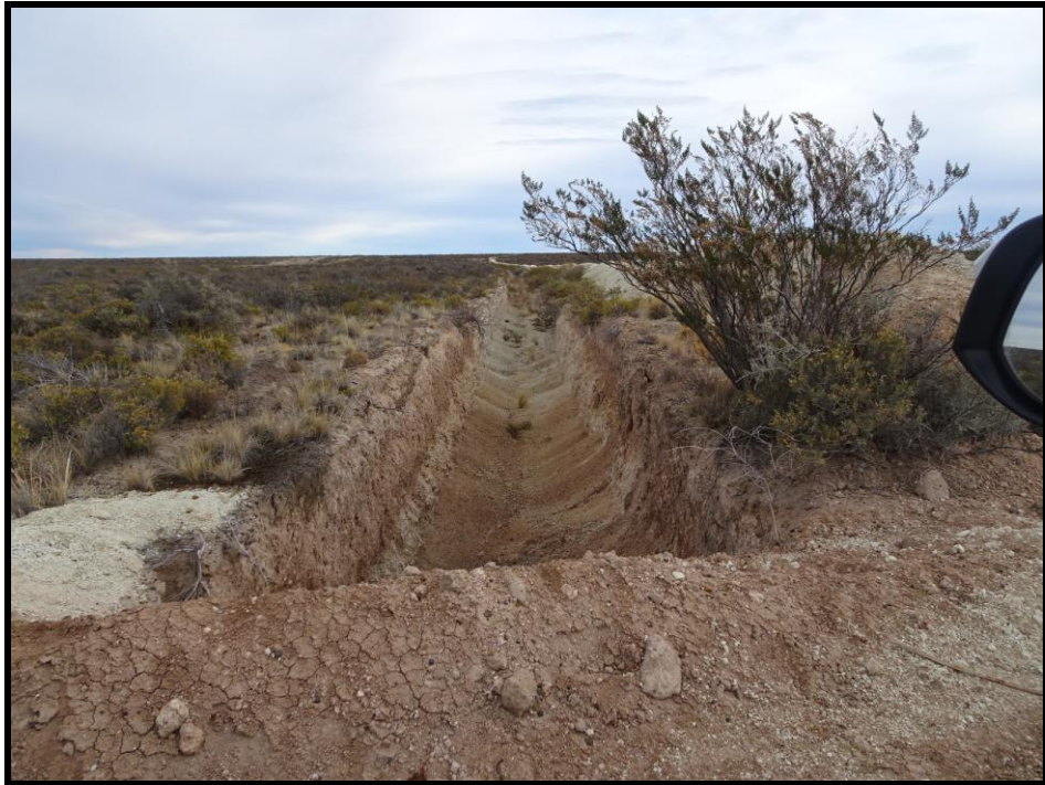
FOTO N° 9: Zanjón en el ingreso al Lote 16B
