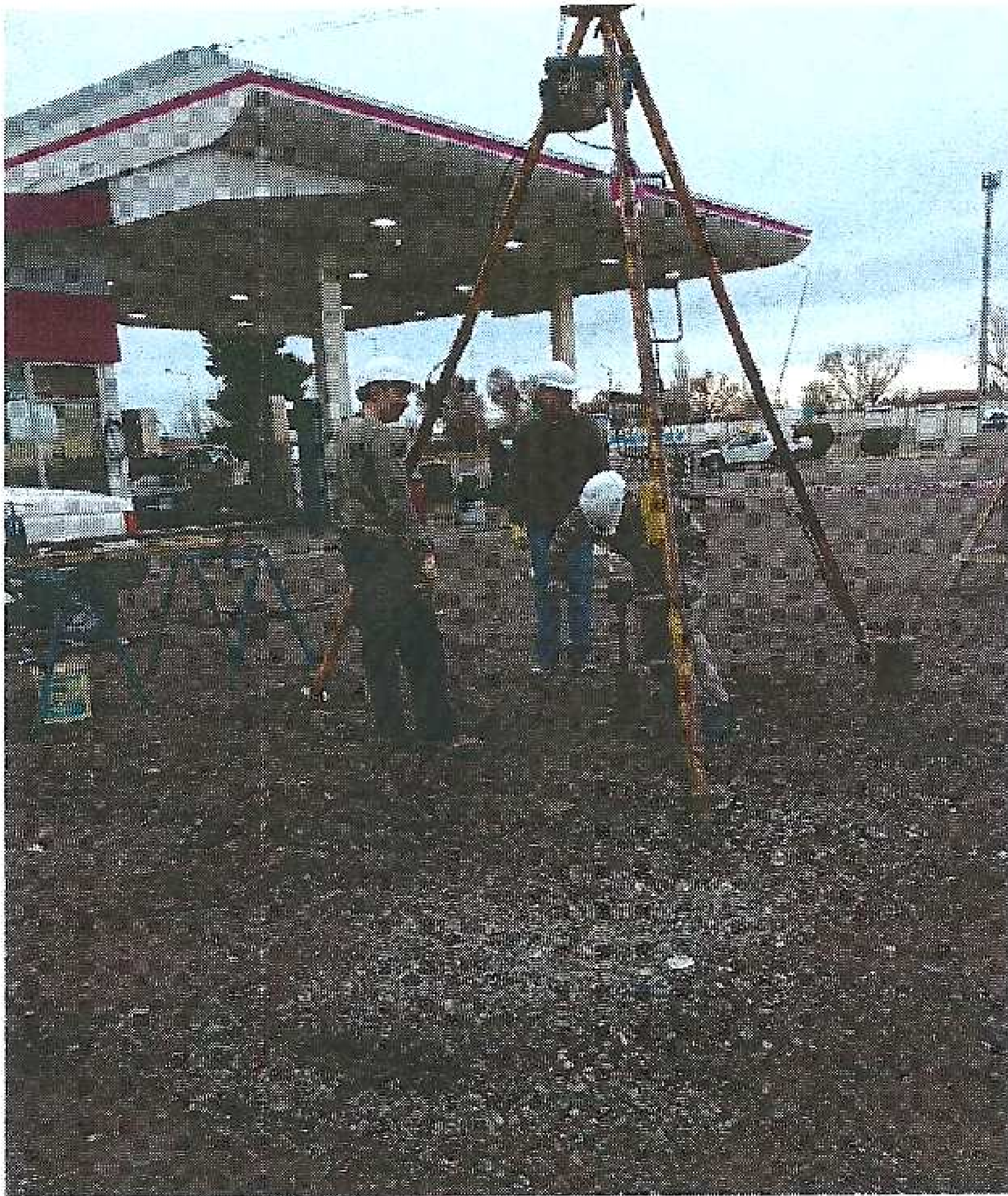
Foto 1. Excavación con Barreno
