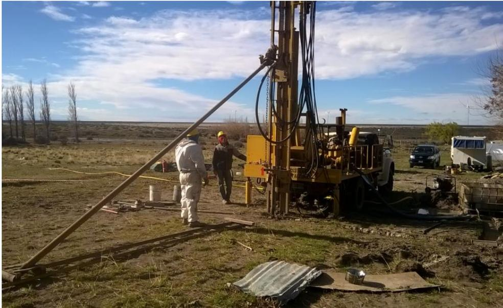
Las tareas de pruebas de permeabilidad en los sedimentos para comprender mejor su capacidad de transporte y permeabilidad, se realizarán durante los ensayos de bombeo y serán reportados en un informe final, que además presentará diseño del pozo y análisis físico / químico de las aguas subterráneas.
