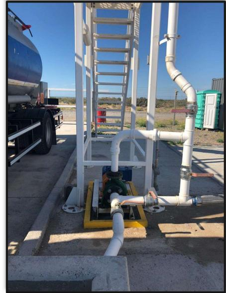
Playa de carga y descarga – Plataforma - Bomba de combustible – Manifold - Tuberías
