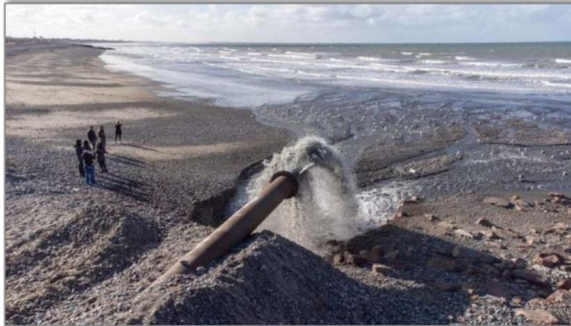
Figura IV.3.c: Cañería para descarga del refulado del río Chubut en Playa Unión.
