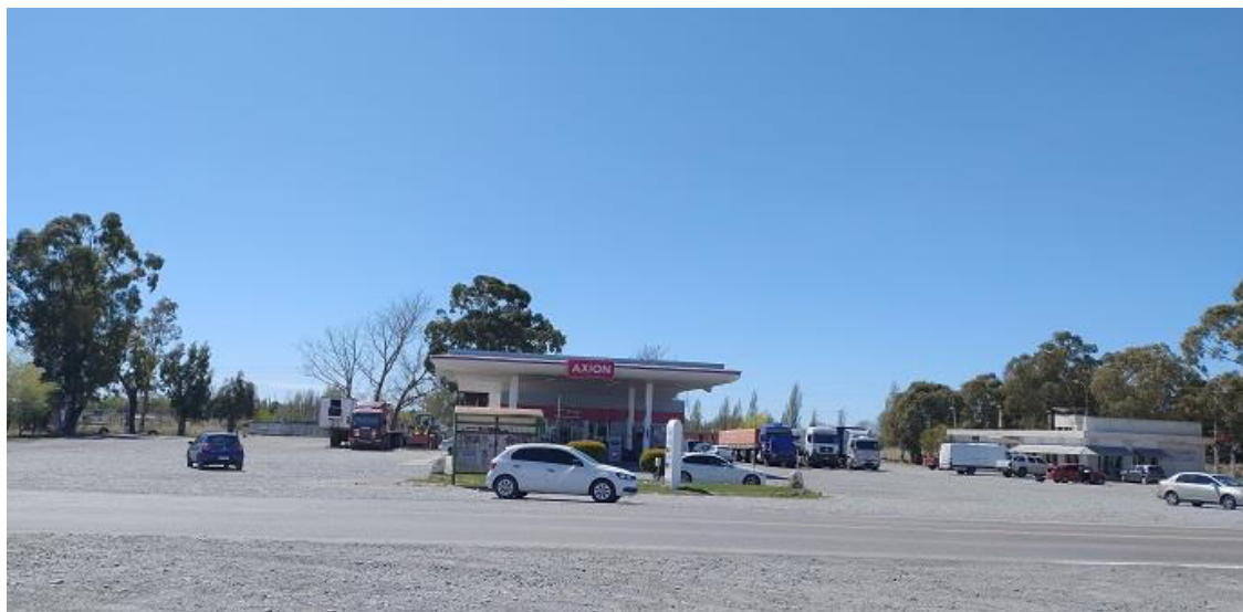
Vista desde el frete de la estación actual
