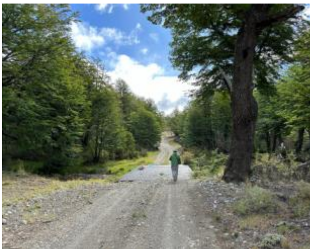
Foto 11: Puente sobre arroyo temporario SE
