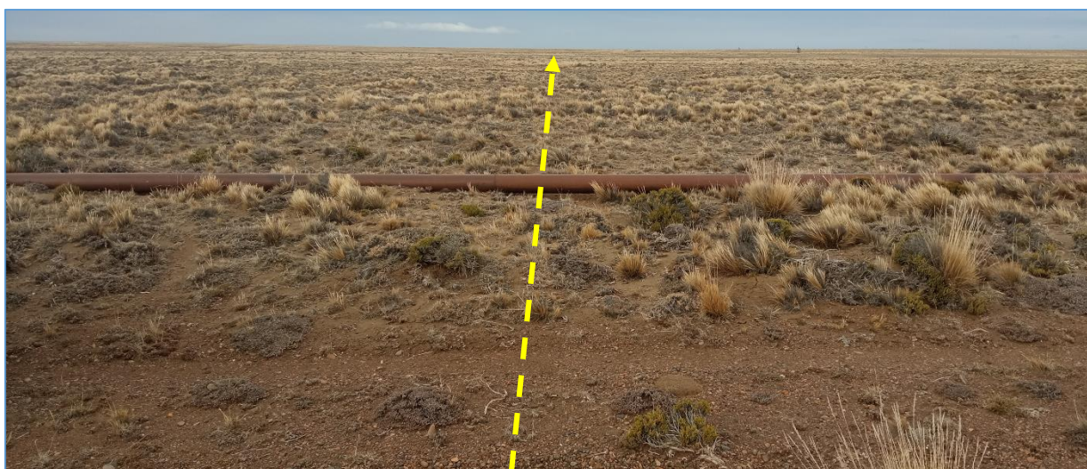
Fotográfico V.34 Línea de tendido eléctrico continúa hacia el SE, atraviesa picada y ducto aéreo.
