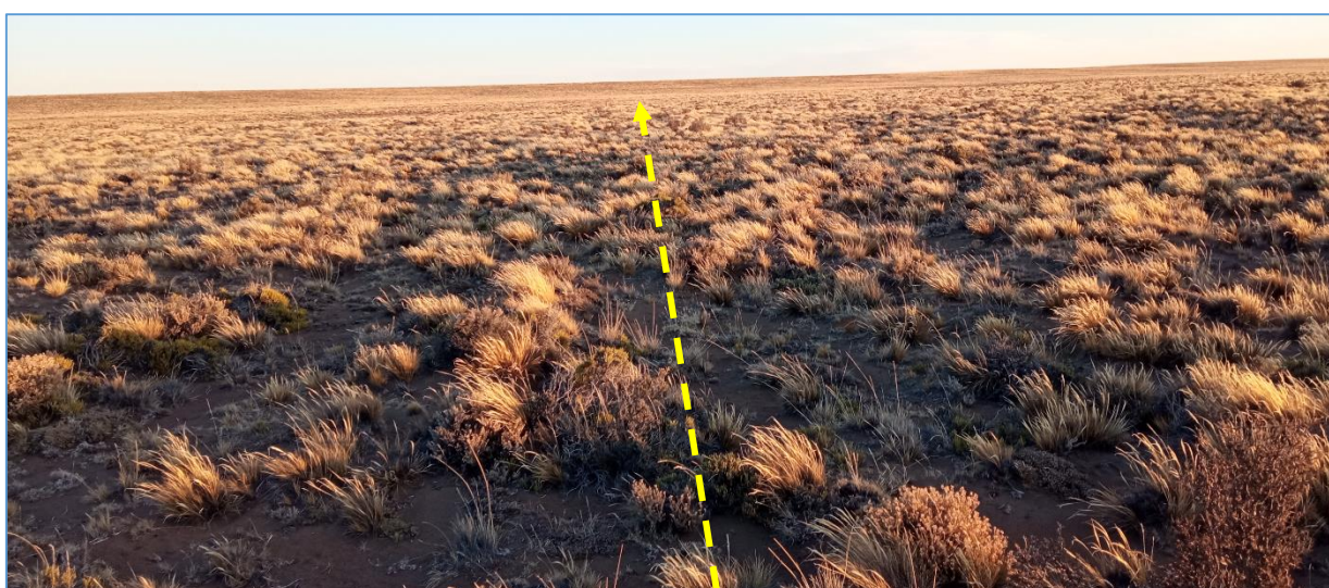
Fotografía V.43 Línea de tendido eléctrico continúa hacia el SO por terreno natural.
