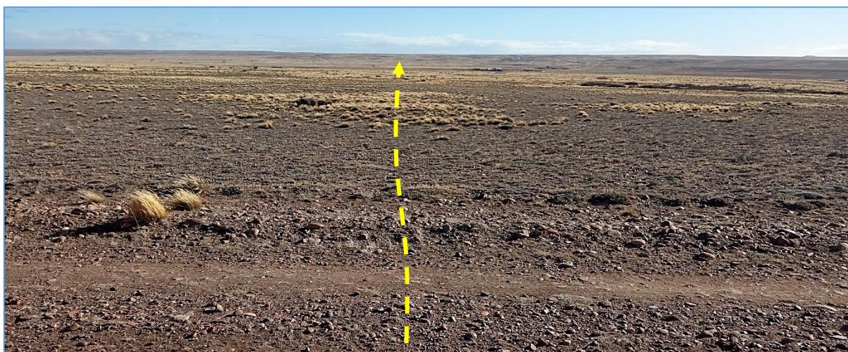
Fotografía V.55 La línea eléctrica cruza picada, continúa hacia el SO.
