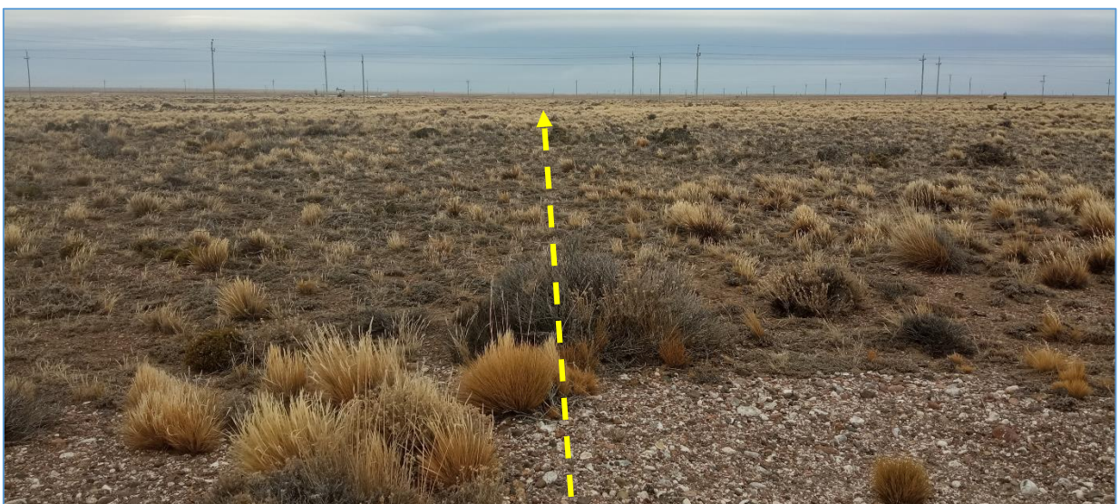
V.31 Línea del tendido eléctrico atraviesa picada y 2 tendidos eléctricos con sentido NE-SO, continúa al SE.
