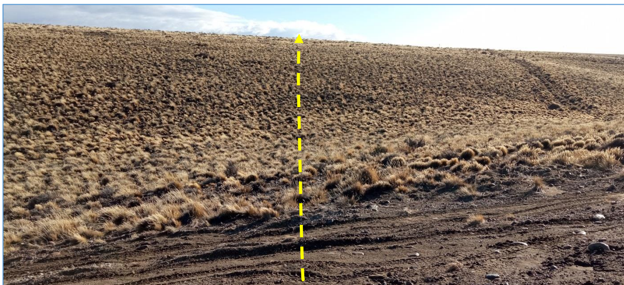
Fotografía V.65 La línea eléctrica cruza 3 (tres) tendidos eléctricos y picada.
