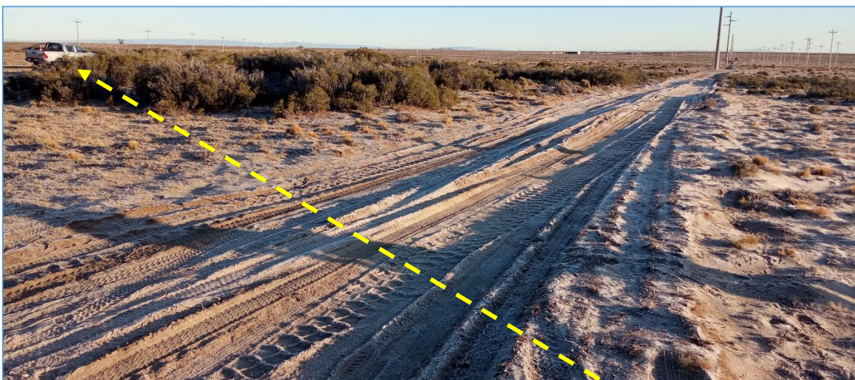
Fotografía V.12 Línea de tendido eléctrico atraviesa camino de acceso hacia ET_R2. Continúa hacia el O-SO.
