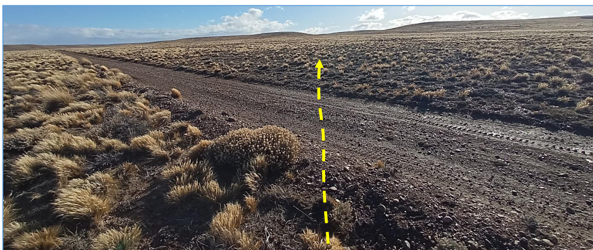
Fotografía V.63 La línea eléctrica cruza camino interno de yacimiento, continúa hacia el NO.
