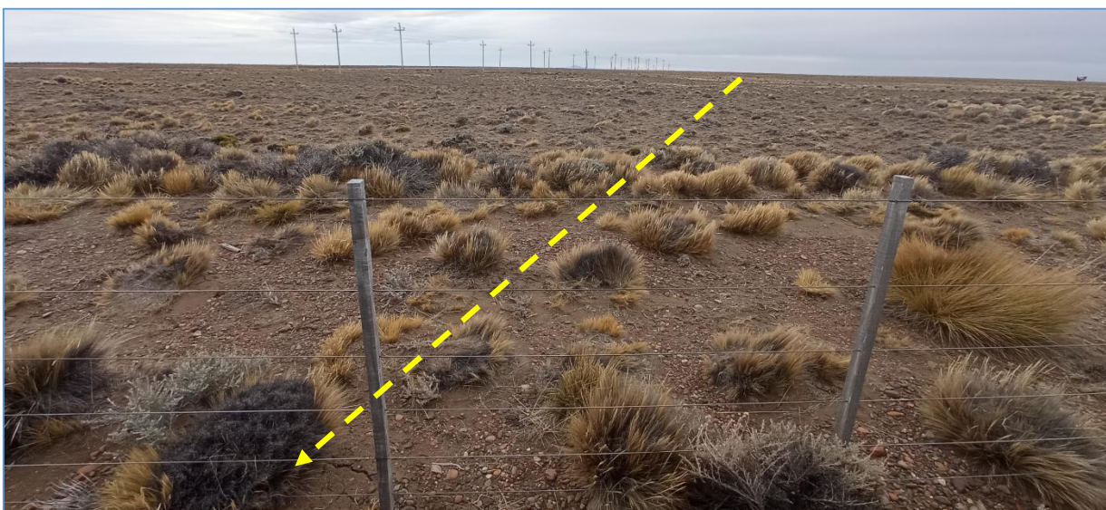
Fotografía V.28 Línea de tendido eléctrico continúa hacia el SO, atraviesa alambrado. Vista hacia el Norte.
