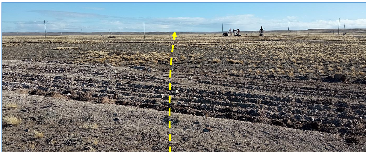
Fotografía V.59 La línea eléctrica cruza picada de ductos escarificada, continúa hacia el O.
