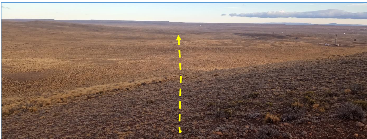
Fotografía V.52 La línea eléctrica continúa hacia el O.
