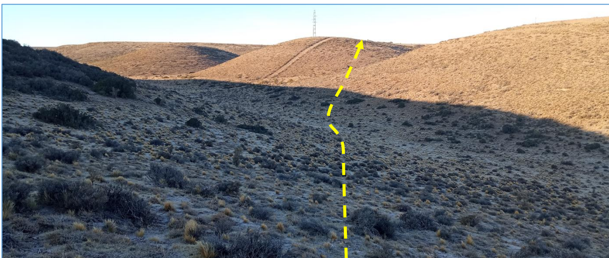
Fotografía V.14 Línea eléctrica continúa hacia el SO atravesando cañadón de sentido NO-SE.
