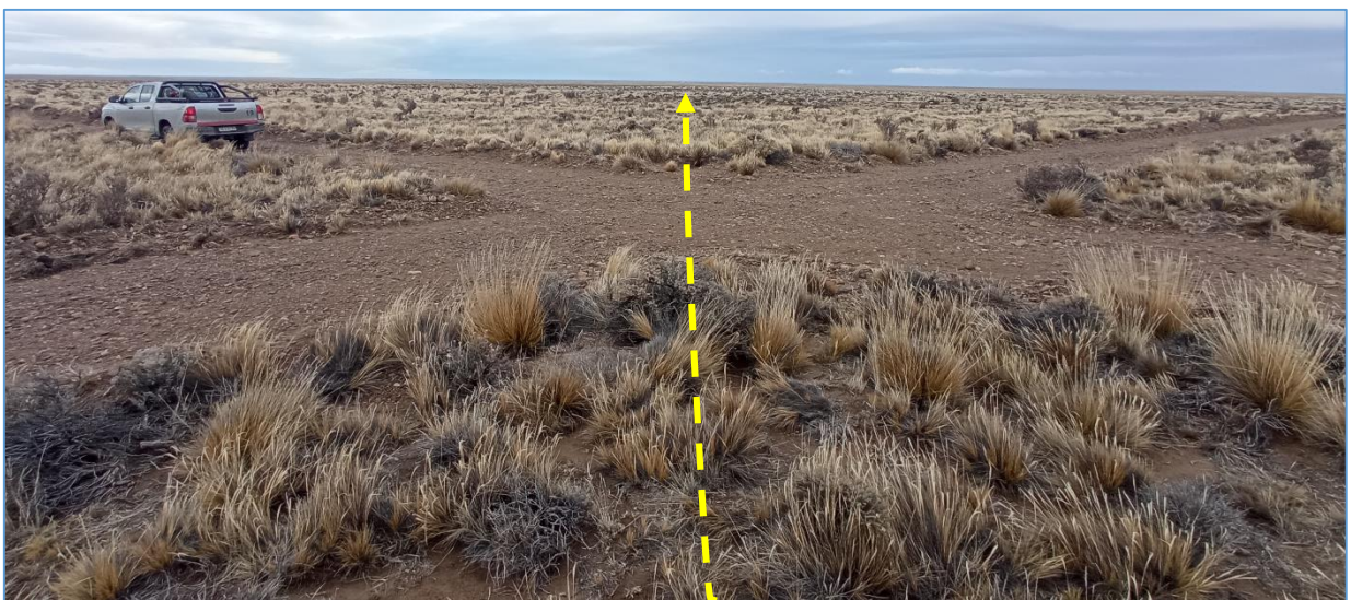
Fotografía V.37 Línea de tendido eléctrico intercepta con 2 caminos, uno en sentido N-S y otro en sentido NE-SO.
