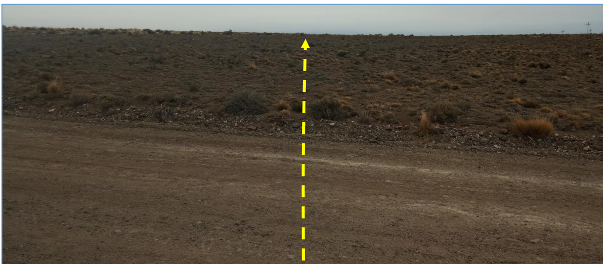
Fotografía V.26 Línea del tendido eléctrico continúa hacia el SO, cruza camino de yacimiento.
