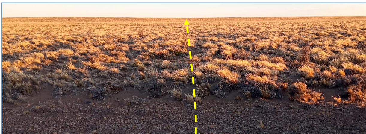
Fotografía V.42 Línea del tendido eléctrico atraviesa picada y continúa hacia el SO.
