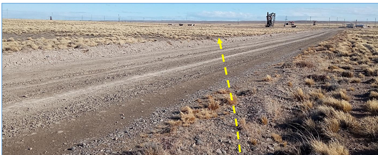
Fotografía V.57 La línea eléctrica cruza camino interno de yacimiento y continúa hacia el SO, en cercanías al margen sur de la locación del pozo PO-817.
