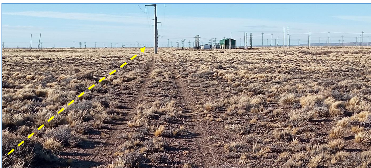
Fotografía V.67 La línea eléctrica continúa el recorrido hacia el NE, paralela a la picada y tendido eléctrico.
