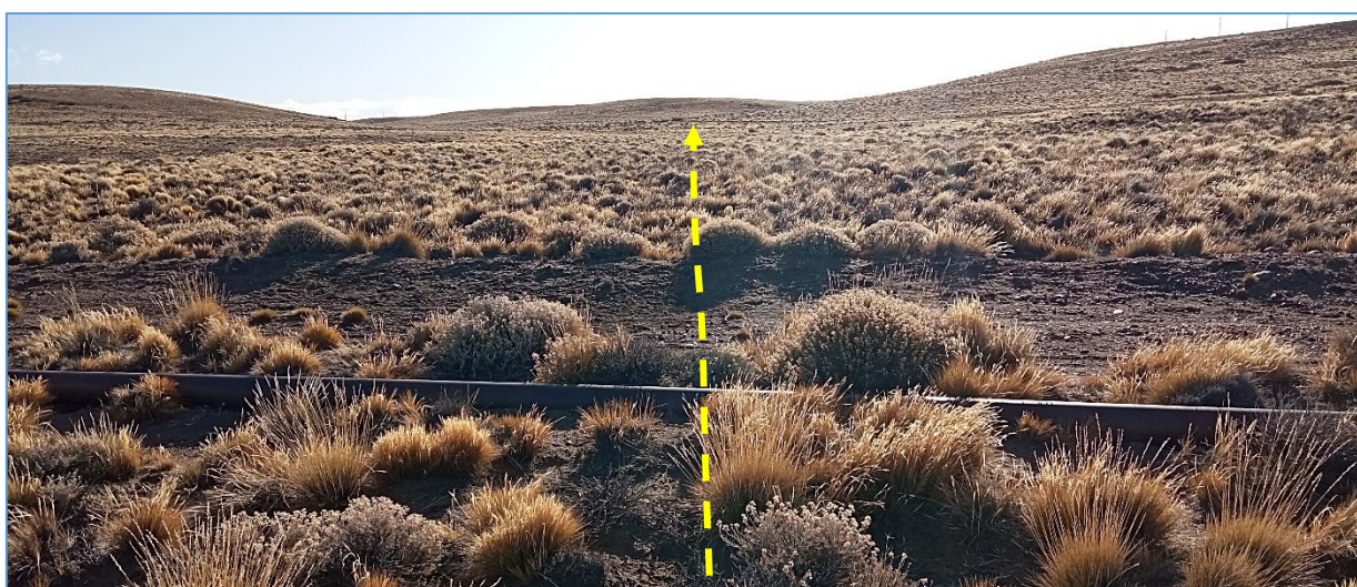
Fotografía V.64 La línea eléctrica cruza camino interno de yacimiento y 3 (tres) ductos aéreos, continúa hacia el NO.
