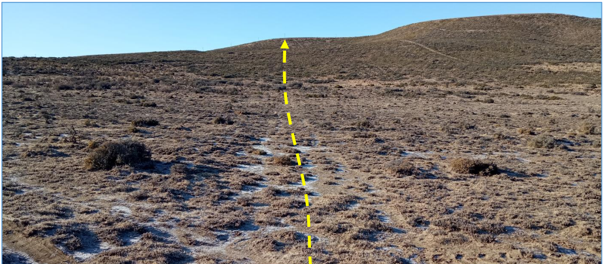
Fotografía V.21 Línea de tendido eléctrico continúa hacia el Este por picada.
