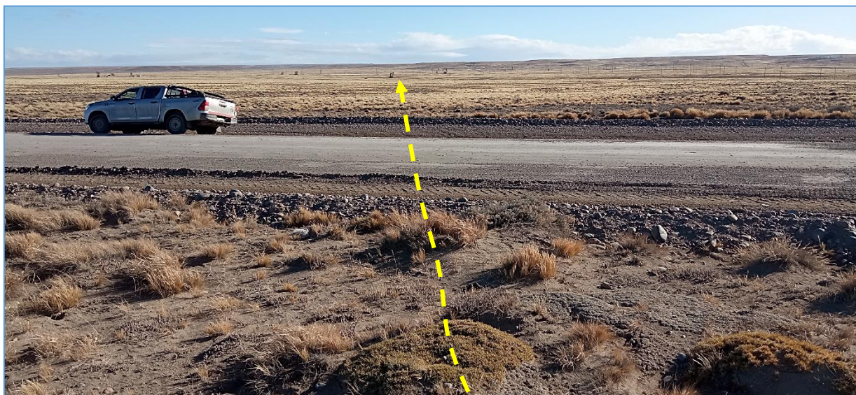
Fotografía V.56 La línea eléctrica cruza camino principal, continúa hacia el SO.
