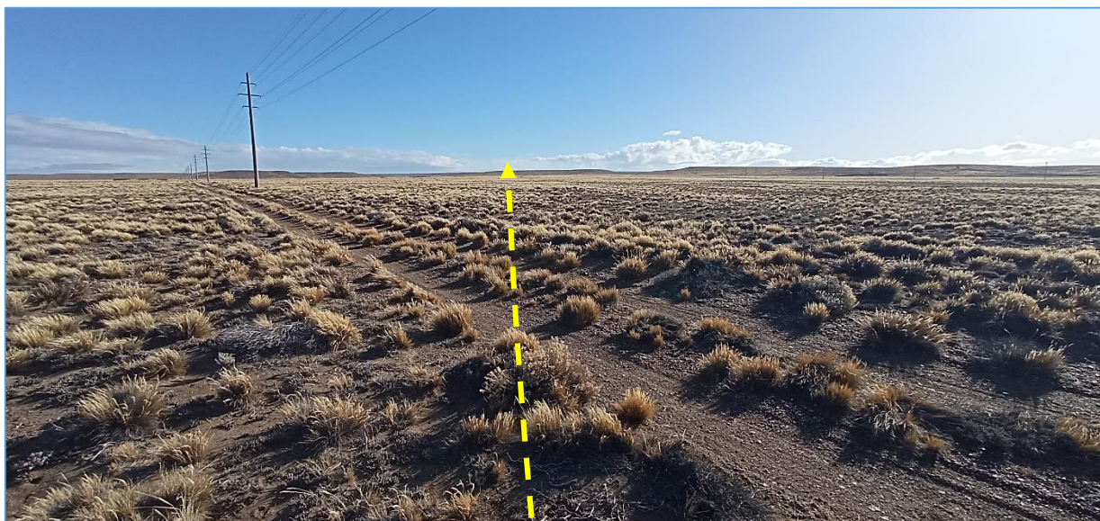
Fotografía V.62 La línea eléctrica cruza picada y tendido eléctrico, continúa hacia el O.
