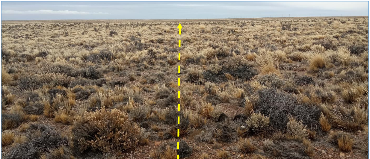
Fotografía V.38 Línea del tendido eléctrico continúa hacia el S-SE por terreno natural.
