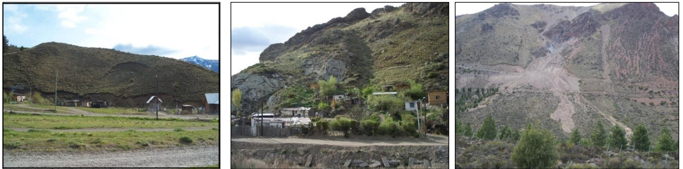
Deslizamiento en el Cañadón de Borquez. Deslizamientos al pie del barrio Ceferino. Flujos de barro camino a La Hoya.
