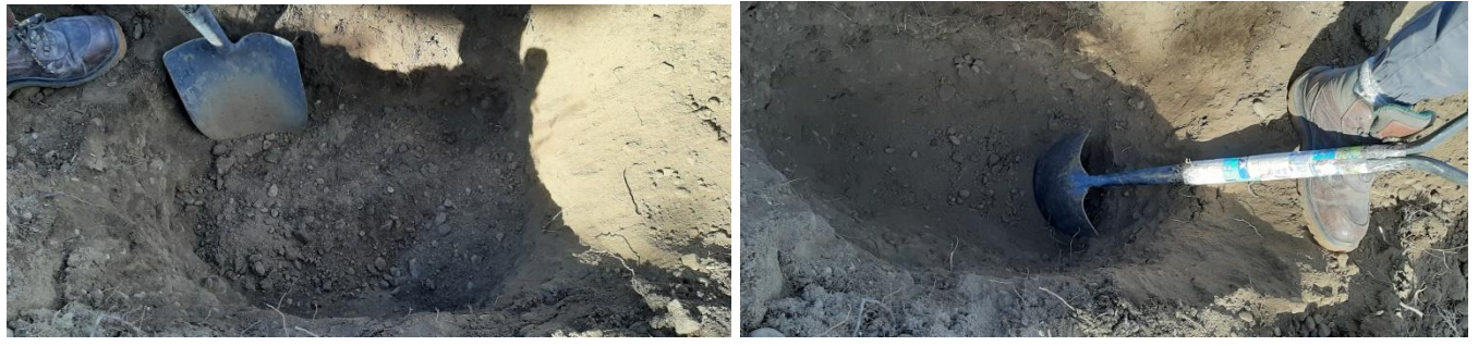
Excavación a mano.
