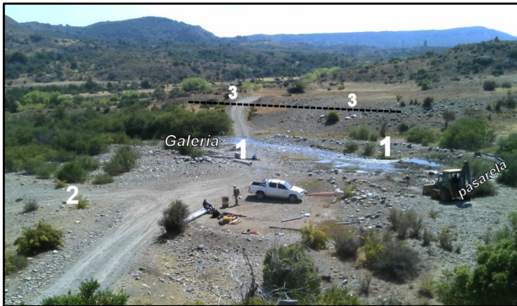
Figura 25. Geomorfología del arroyo Buitrera. 1: Barras fluviales ocupadas por el cauce de estiaje y el de crecientes ordinarias; 2: Terraza intermedia que está vegetada, 3: Terraza superior con gravas. Fuente: ConsulTech.
