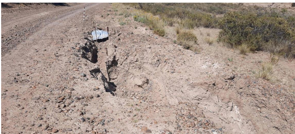
Fotografía 37. Signo de erosión hídrica. Inicio de una cárcava.
