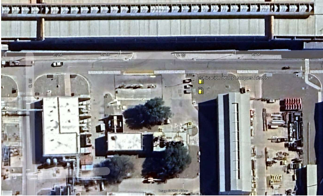
Figura 3: Imagen satelital con la ubicación de los Tanques de Aéreos de Combustible (TAC).
