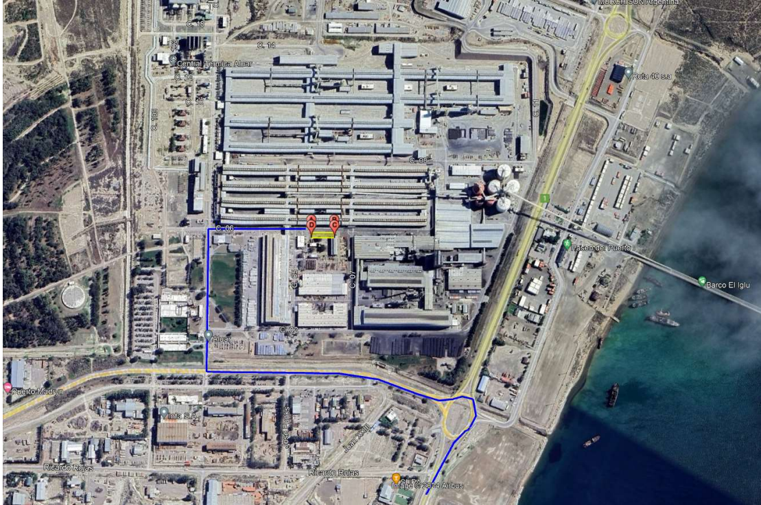
Figura 9: Vía de acceso terrestre al Proyecto.
