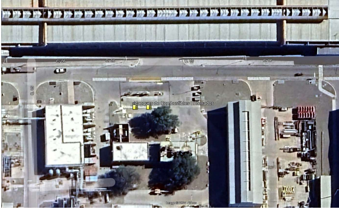
Figura 2: Imagen satelital con la ubicación de los Tanques de Combustible Actuales (TCEP).
