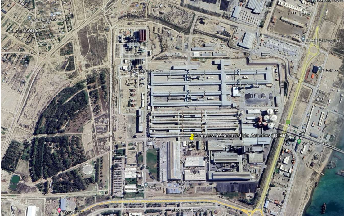
Figura 1: Imagen satelital de la Planta Aluar Aluminio Primario, con la ubicación de los Tanques de Combustible de la Estación Primario (TCEP).
