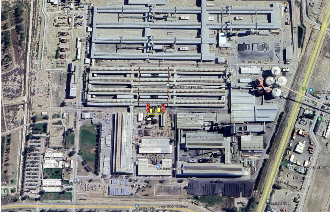
Figura 6: Polígono ABCD vista desde lejos para clarificar su ubicación (sitio donde se efectuará el cambio de Tanques).
