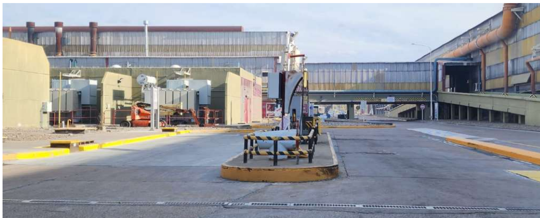
Figura 4: Imagen actualizada de la zona de expendio de combustible (instalación actual).
