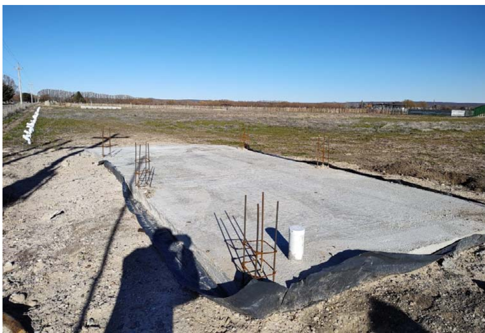
Imagen 12: Platea para futura casta para el generador.
