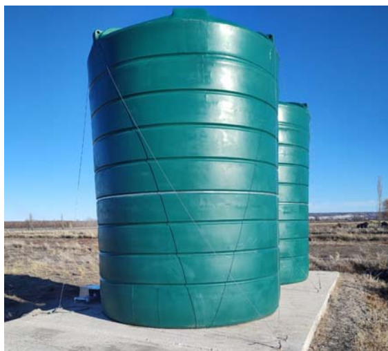
Foto 2: Tanques de 25.000 Lst c/u de almacenamiento de agua de perforación para consumo animal.
