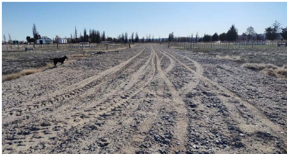
Foto 1: Construcción de calle interna entre corrales.
