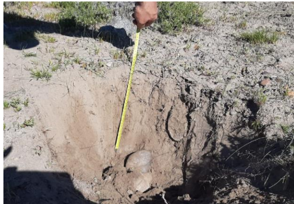
Imagen 27: Detalle de calicata
