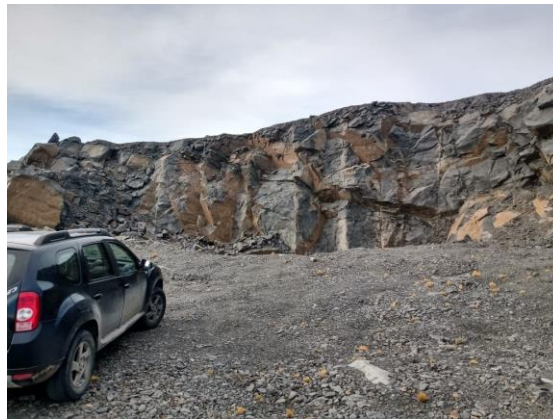
Imagen 16: Frente de cantera, se observan dos familias de discontinuidades sub-verticales
