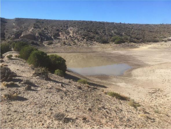
**Foto 5** Vista al E de un dique artificial antiguo sobre un cauce efímero que corre N-S y que sirve de aguada de estancia. Sobre la Formación Río Chico.  $45^{\circ}19'37,99''S$  -  $67^{\circ}41'52,11''O$ .
