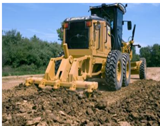
Fotografía N° 39/40 Escarificado pos cierre de la cantera de playa de maniobras, caminos y picadas abiertas durante la operación minera
