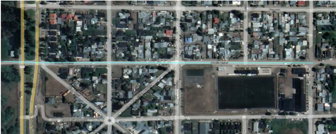
Imagen N°5: Colector Tramo Calle Alsina
