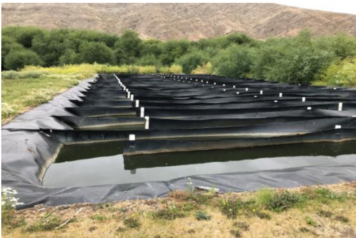
Imagen N°38: Cámara de Contacto
