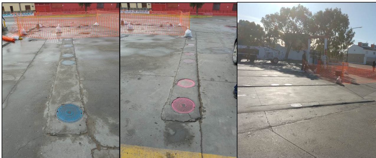
Fotografía 6: Tanque 3 (izq.), Tanque 2 (centro) y Tanque 1 (der.).
