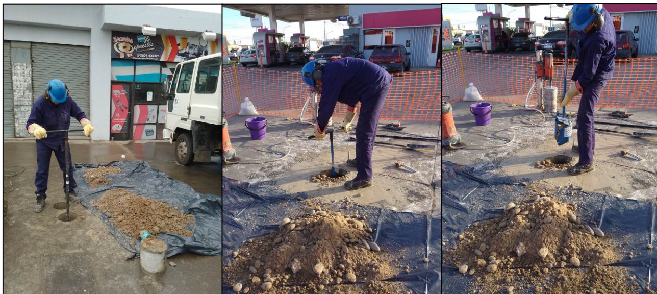
Fotografía 8: Perforación manual hasta los 2 m.b.n.s.
