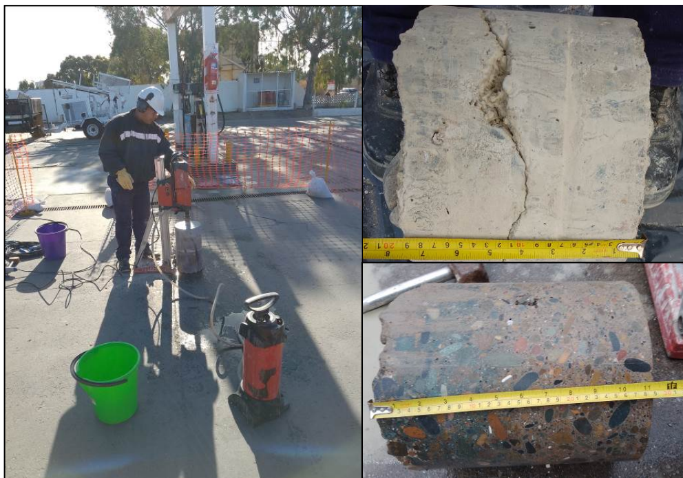
Fotografía 8: Corte de playa de hormigón armado.
