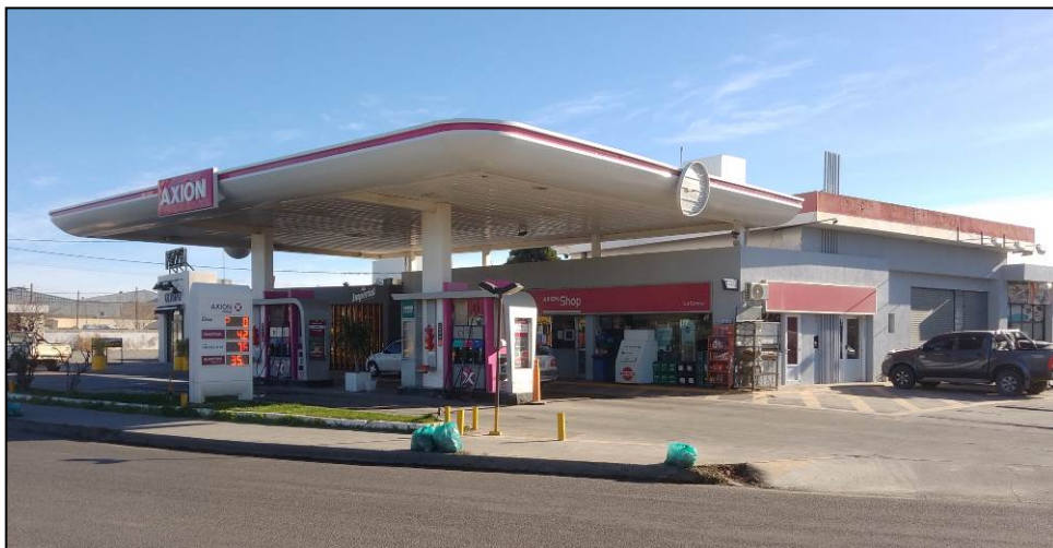
Fotografía 1: Vista de Islas y Shop sobre Av. Libertad.
