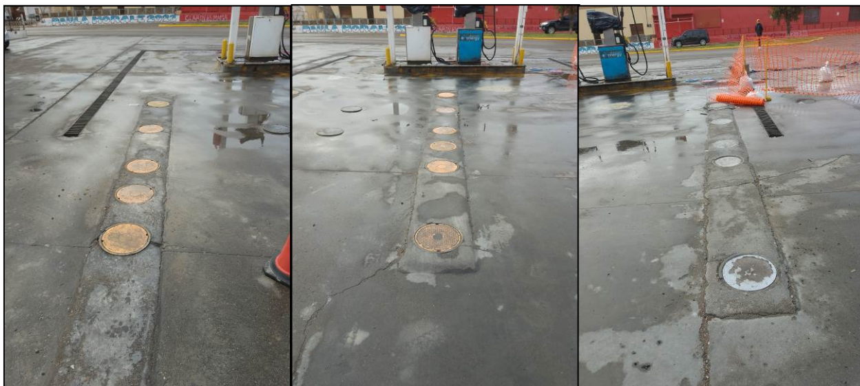
Fotografía 5: Tanque 6 (izq.), Tanque 5 (centro) y Tanque 4 (der.).
